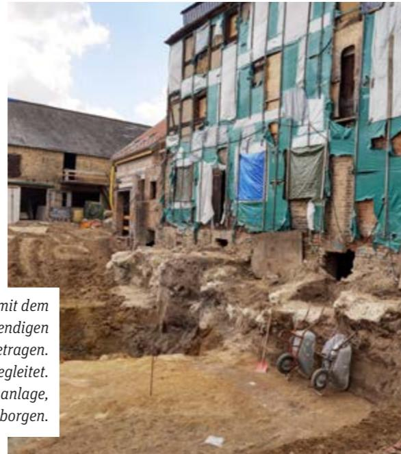
*Direkt neben dem Brauereigebäude wurde mit dem Bau einer Tiefgarage begonnen, um Platz für die notwendigen Stellplätze zu schaffen. Stück für Stück wird der Boden abgetragen. Die gesamte Maßnahme wird von der Bodenarchäologie begleitet. Einige kleinere Funde, wie z.B. eine Brunnenanlage, wurden bereits geborgen.*
