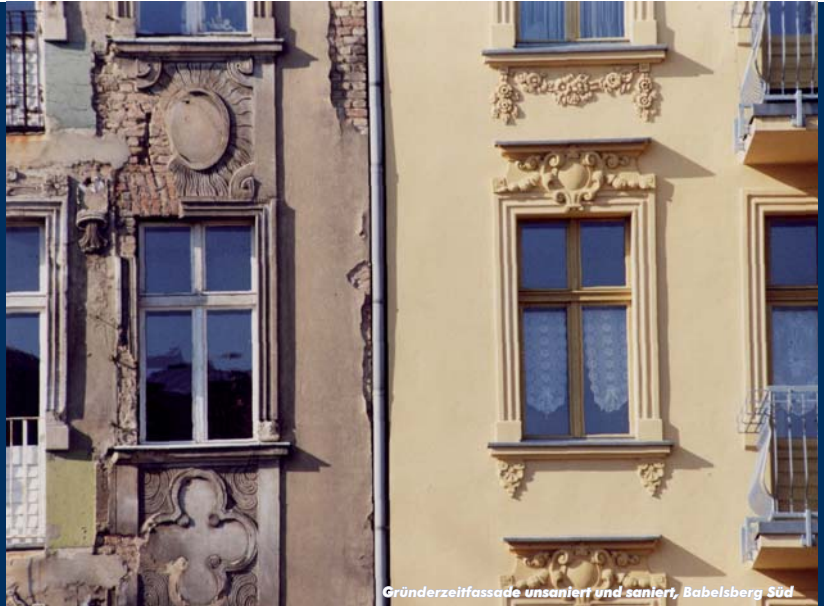
Gründerzeiffassade unsaniert und saniert, Babelsberg Süd
