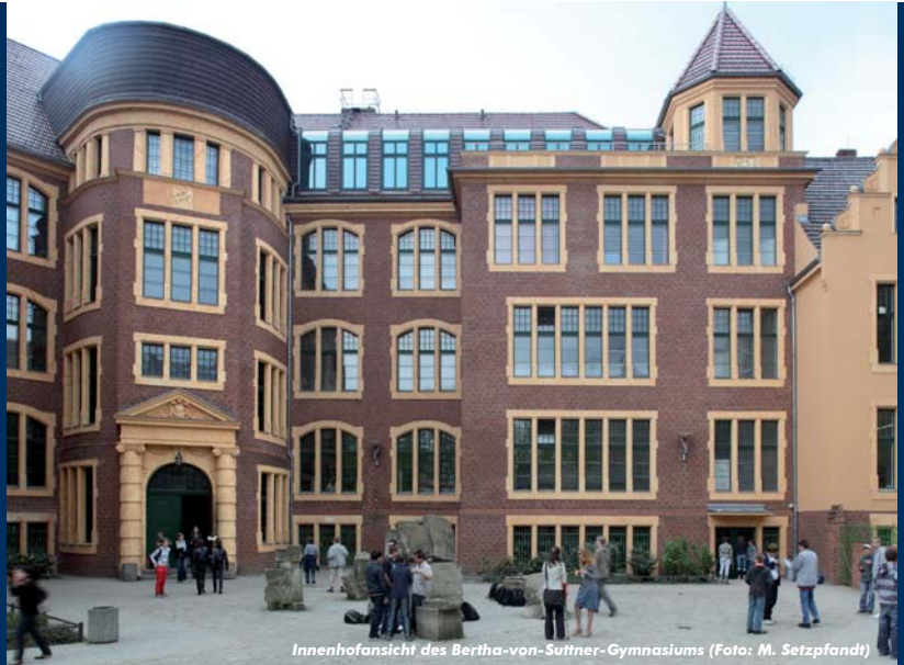
Innenhofansicht des Bertha-von-Suttner-Gymnasiums (Foto: M. Setzpfandt)
