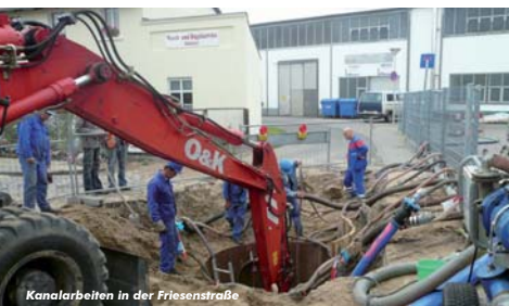
Kanalarbeiten in der Friesenstraße
