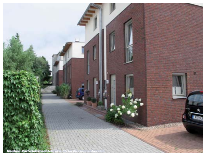
Neubau Karl-Liebknecht-Straße 36 im Blockinnenbereich
