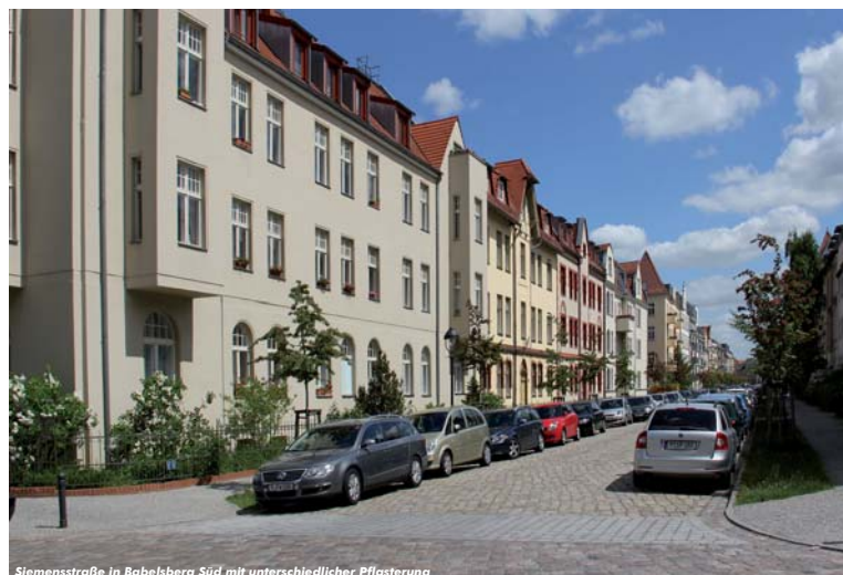
Siemensstraße in Babelsberg Süd mit unterschiedlicher Pflasterung
