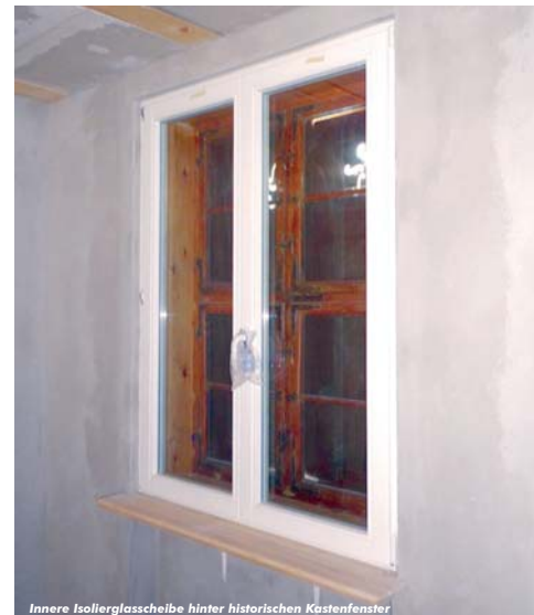
Innere Isolierglasscheibe hinter historischen Kastenfenster
