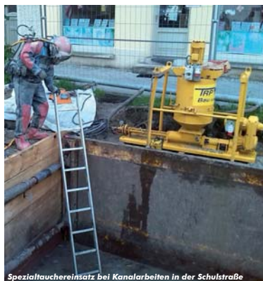
Spezialtauchereinsatz bei Kanalarbeiten in der Schulstraße
