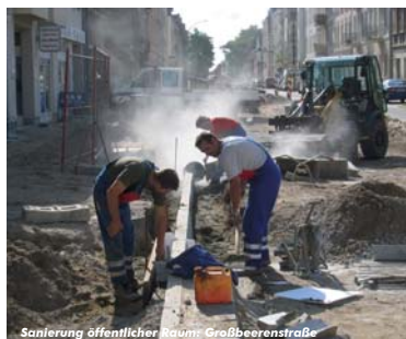
Sanierung öffentlicher Raum: Großbeerenstraße
