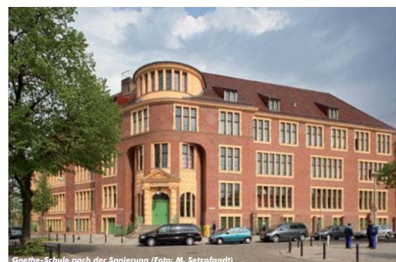
Goethe-Schule nach der Sanierung (Foto: M. Setzpfandt)
