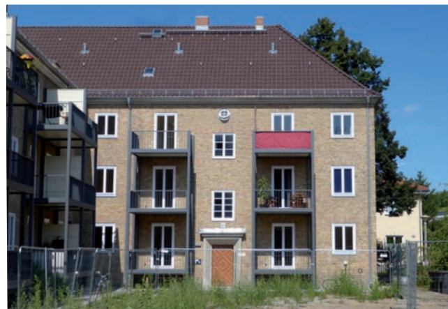
Die neuen Balkone sind zum Innenhof ausgerichtet
