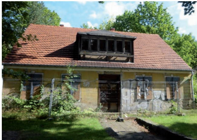
Das Heidehaus ist derzeit mit Bauzäunen gesichert
