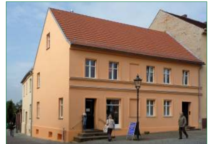
...und nach der Sanierung
