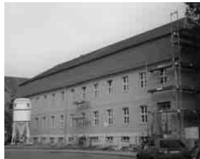
Sanierte Fassade der Geschwister-Scholl-Schule
