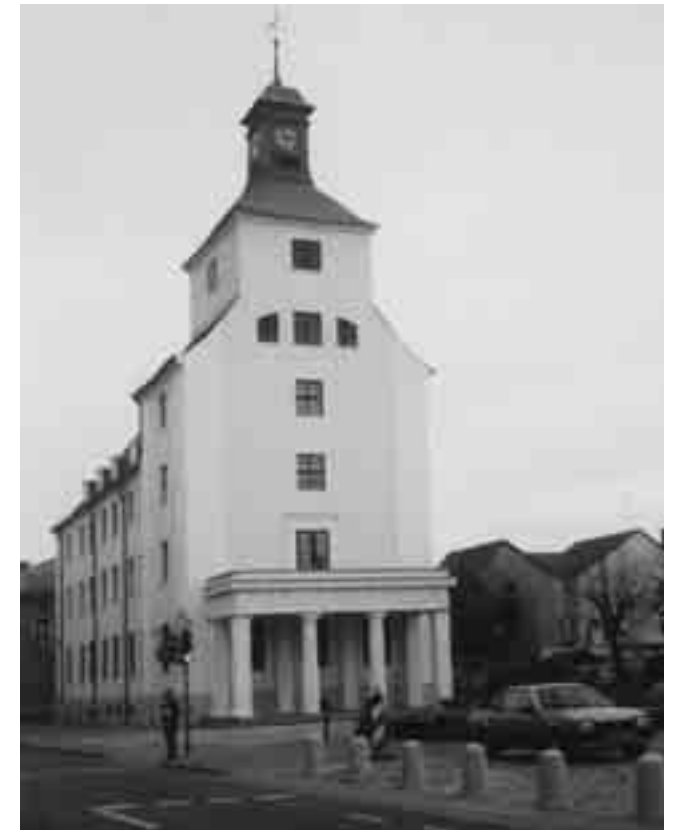
Rathaus Treuenbrietzen, Hüllenförderung B.3.2
