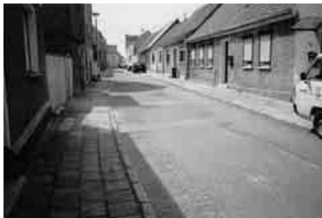
Schulstraße im unsanierten Zustand
