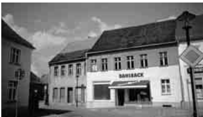
Großstraße 77/78 im unsanierten Zustand
