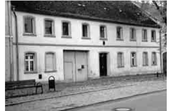
Großstraße 25 vor Sanierung
