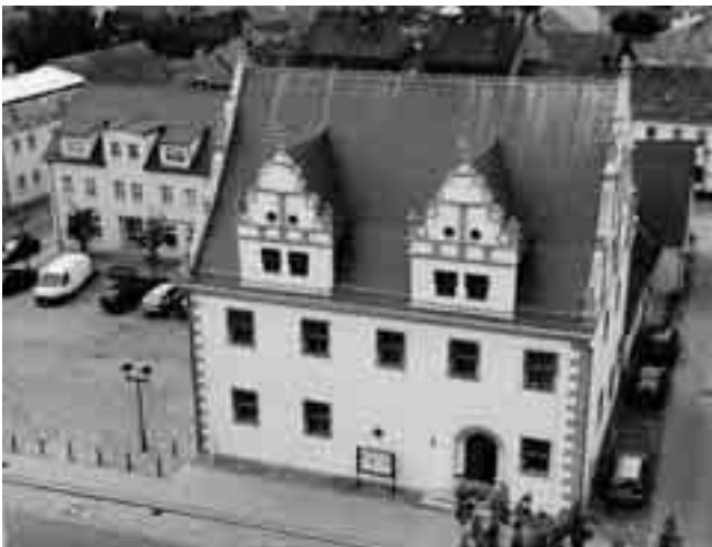
Rathaus nach Abschluss der Sanierung
