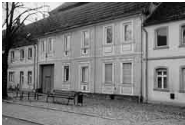
Großstraße 26 im unsanierten Zustand
