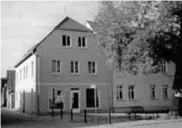
Großstraße 29 nach Fertigstellung
