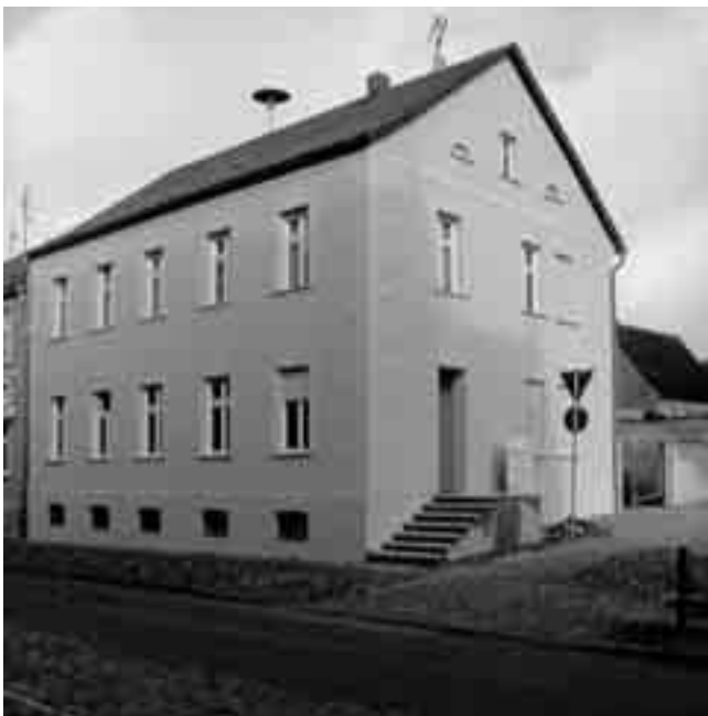
Großstraße 71 nach Abschluss der Sanierung
