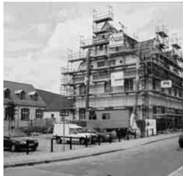
Historisches Rathaus im Bau
