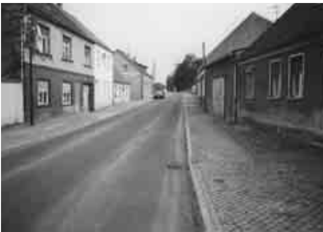
Straße der Jugend nach Abschluss der Bauarbeiten
