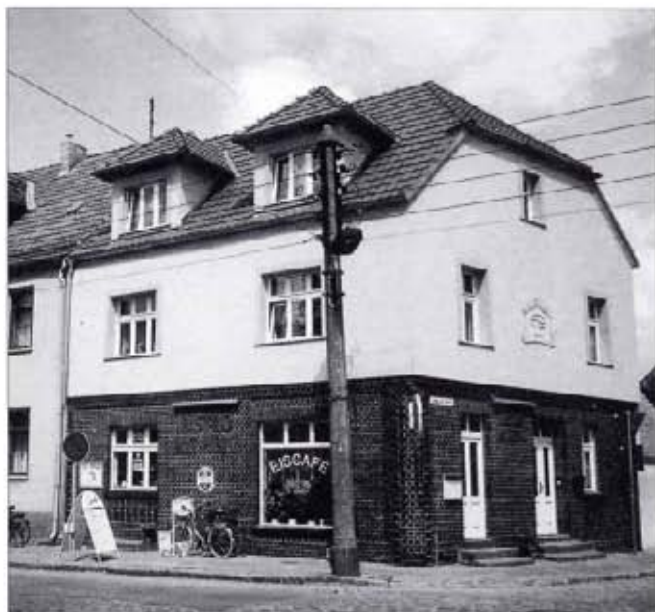
Straße der Jugend 31, Ecke Großstraße
