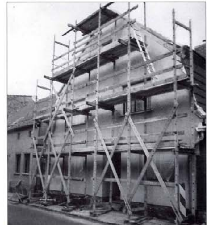
Belziger Straße 2 während der Sanierung
