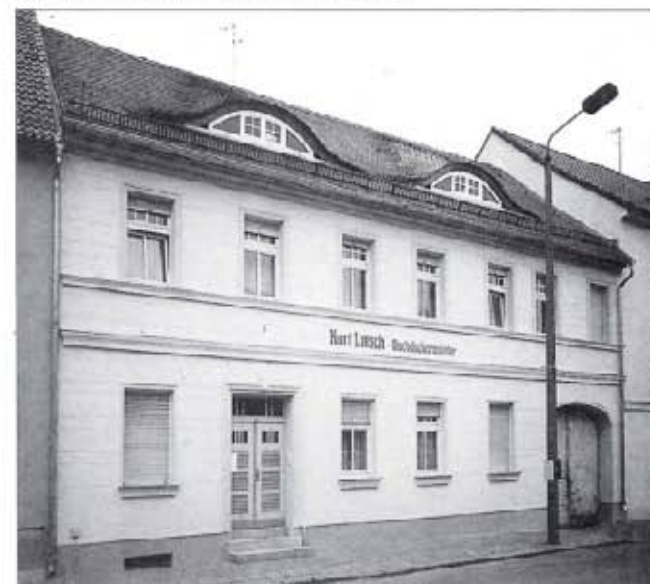
Großstraße 64 nach Abschluß der Sanierungsarbeiten
