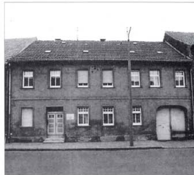
Großstraße 64 vor der Sanierung
