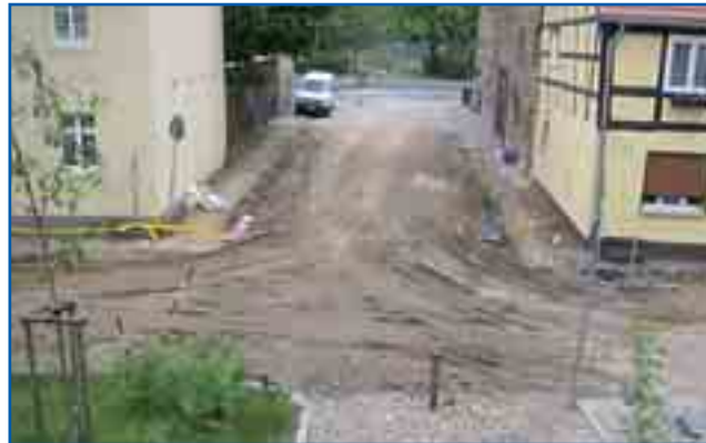
Neue Straße während der Bauphase
