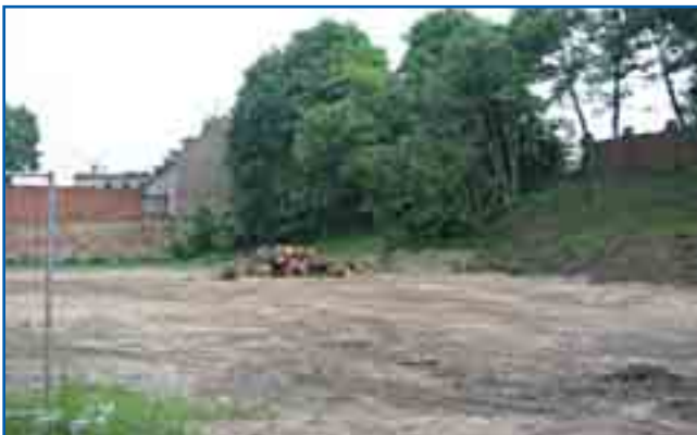
Heizhausgrundstück nach der Freilegung
