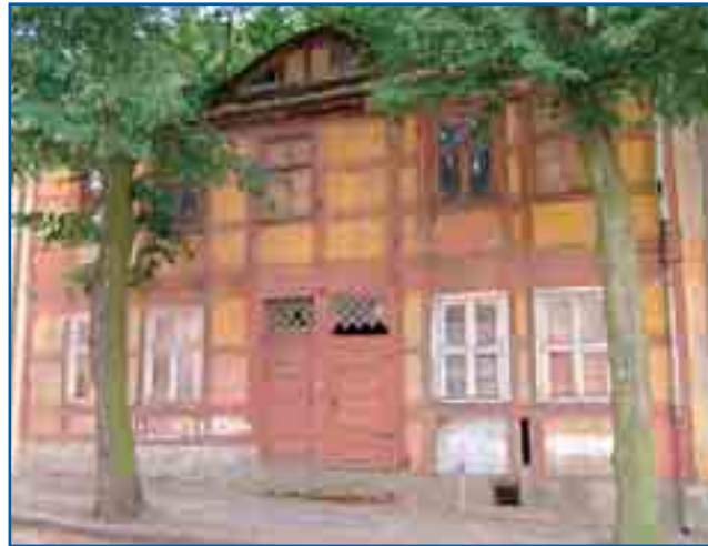
Bergstraße 15 – vor der Sanierung
