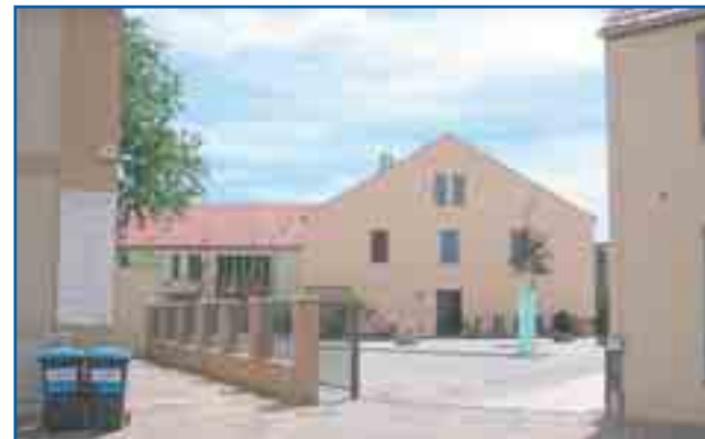
Eingangsbereich des Altenpflegeheims
