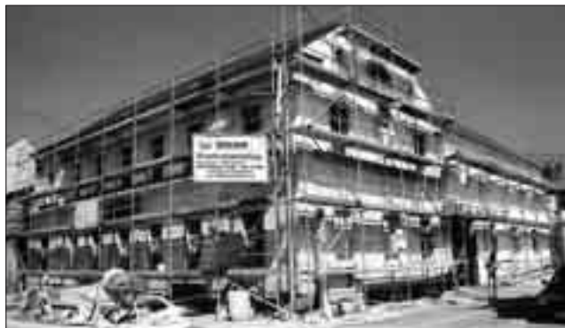
Mittelstraße 28 „Sanierung in der Durchführung“
