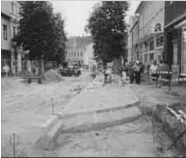
Marktstraße in der Bauphase
