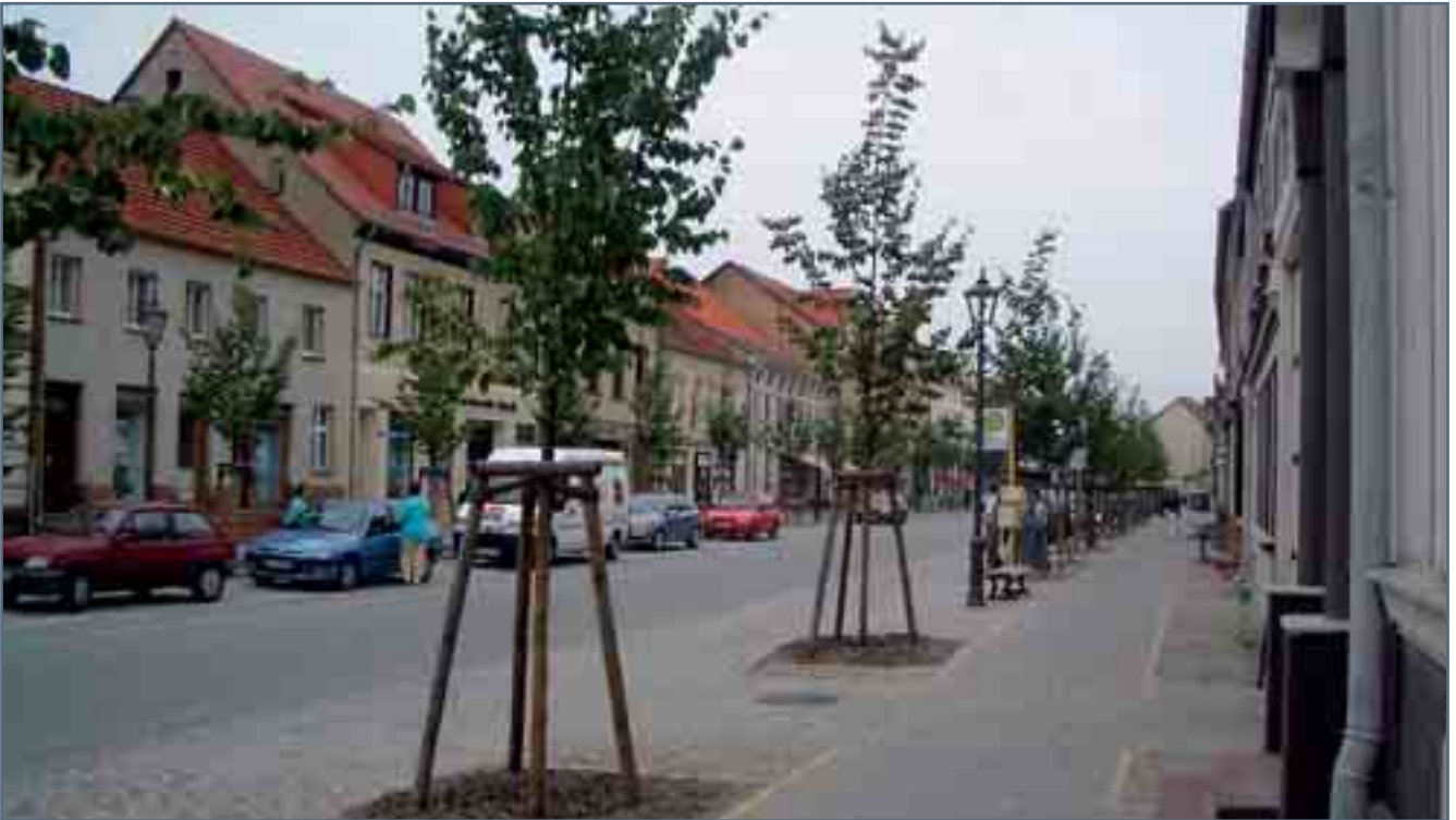
Instandgesetzte Berliner Straße
