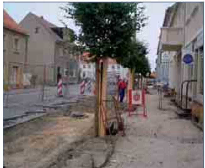
Bauarbeiten in der Poststraße
