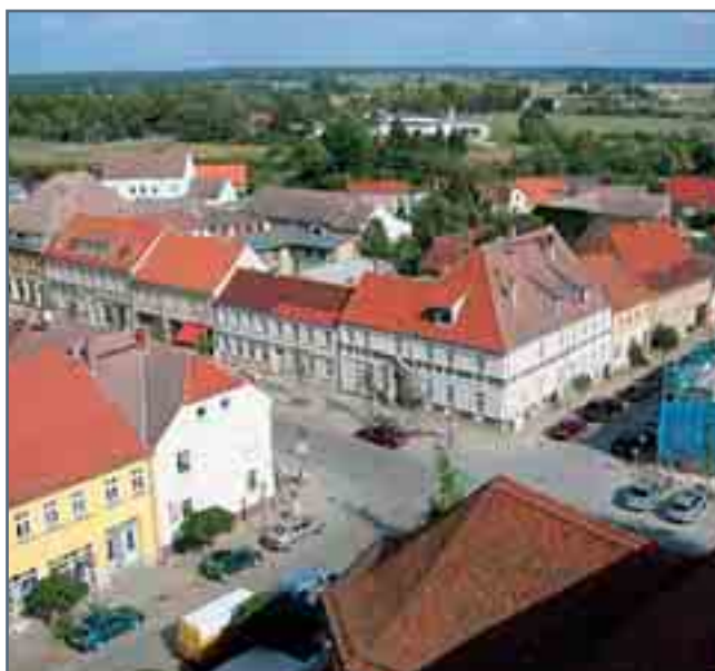
Kreuzungsbereich Berliner Straße/Brauerstraße/Edelstraße
