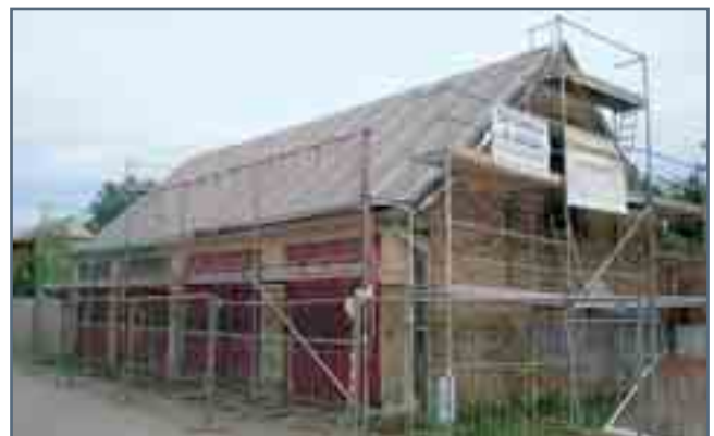
Das Scheunengebäude in der Mauerstraße
