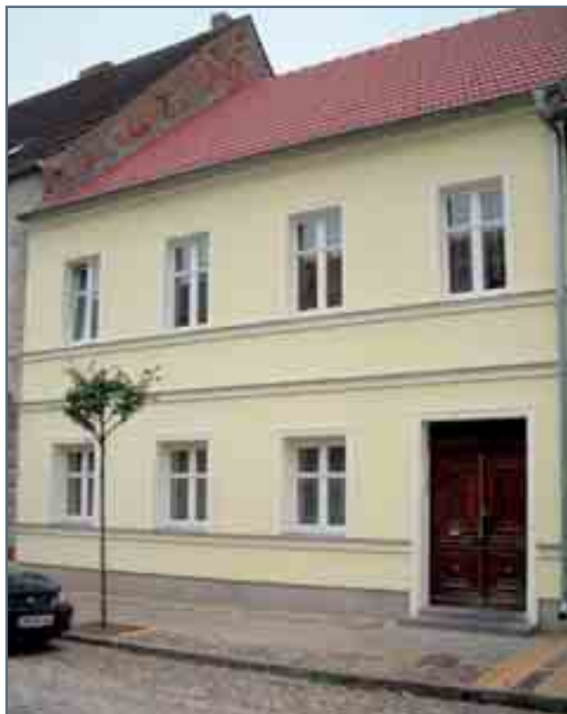
Grünstraße 4 – Fassadensanierung ohne Förderung
