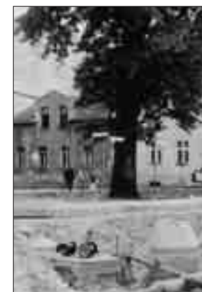
Lutherplatz während der Bauarbeiten
