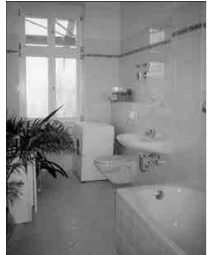
Badezimmer nach Sanierung
