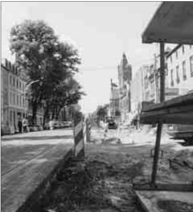
Bauarbeiten in der Rudolf-Breitscheid-Straße
