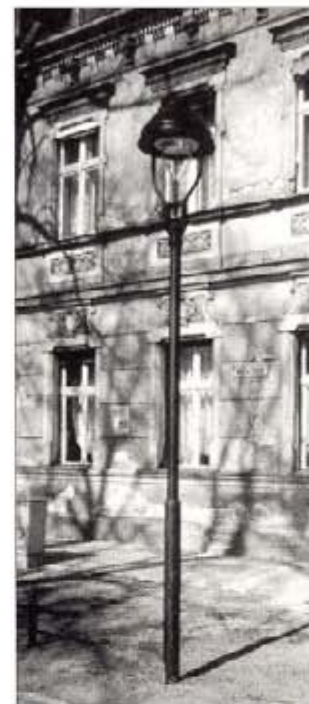
Oben: Leuchte am Weberplatz, Typ »Tuchmacherstraße« Rechts: Individuelle Fensterfertigung für ein Weberhaus Unten: Haus Karl-Liebnecht-Straße 23 Haus Großbeerenstraße 30 Spielplatz Anhalt-/Althoffstraße
