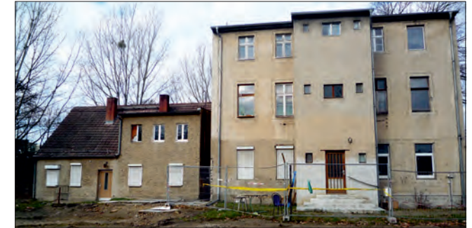
Hofansicht der unsanierten Gebäude Mühlenstraße 2 und 2 A
