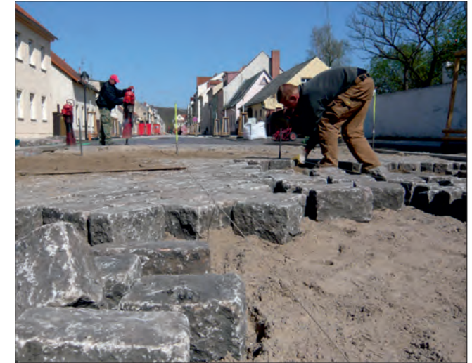
April 2011: Pflasterung der Fahrbahn in der Wollestraße
