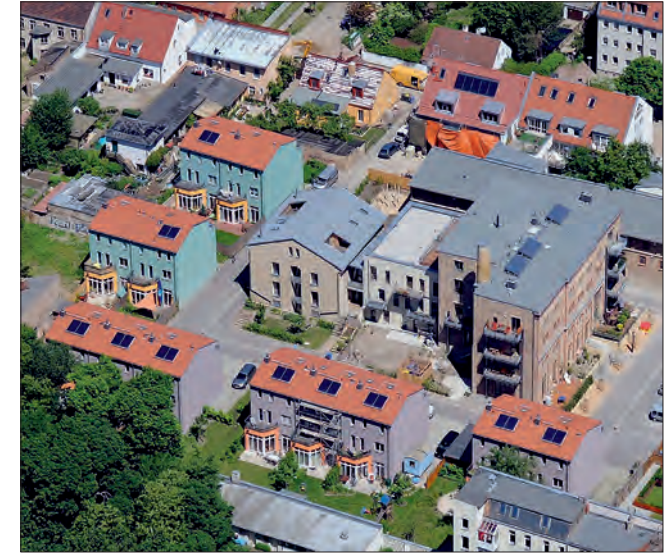
Solaranlage auf den Dächern der Stadthäuser An der Alten Brauerei
