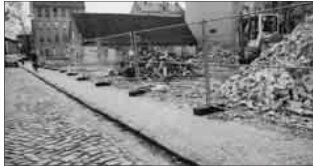
Alt Nowawes 100, Freilegungsarbeiten
