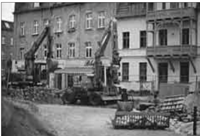
Straßenbauarbeiten am Goetheplatz
