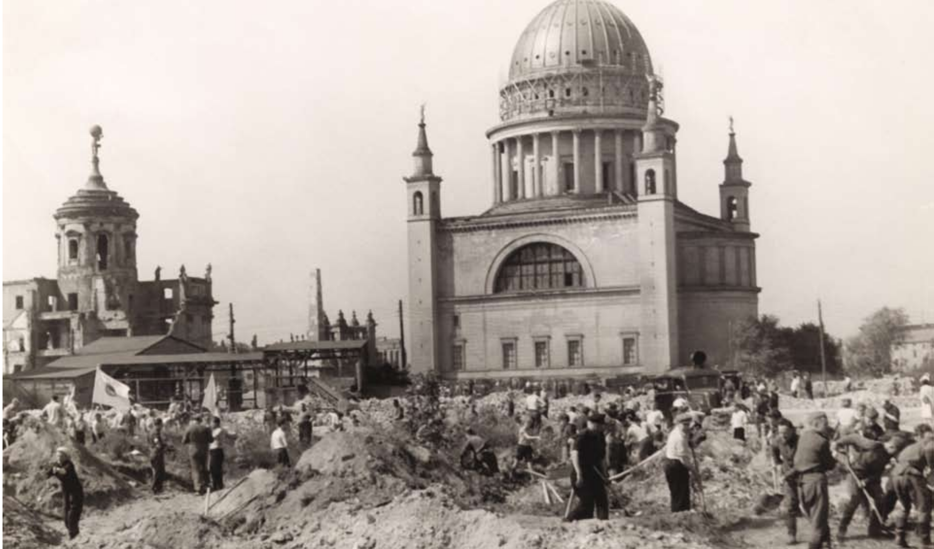
Aufbauarbeiten im Bereich Zentrum Süd 1957
