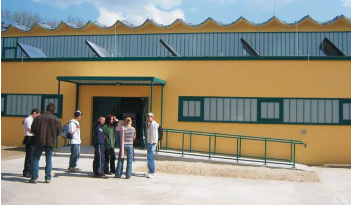
Nach der ökologischen Sanierung der Weidenhof-Turnhalle ist diese auch in den Ferien für den Freizeitsport geöffnet
