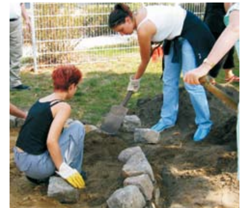
Bau der Kräuterspirale
