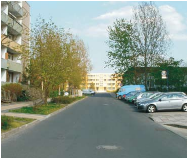
Erneuerung Straße und Gehwege Schilfhof
