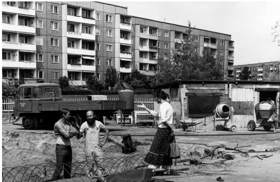
Bau eines Spielplatzes in Potsdam West
