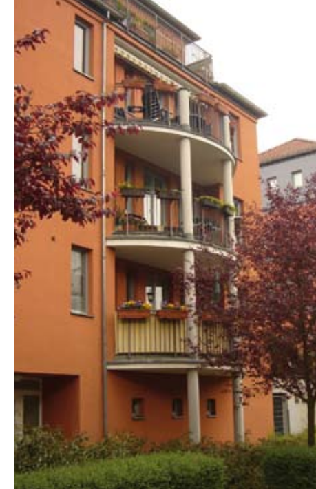
Bebauung im Kirchsteigfeld
