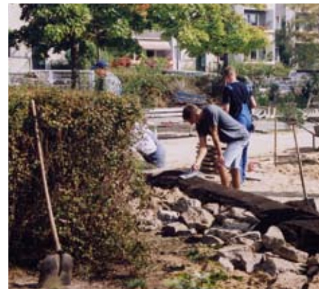
Aus alten Gehwegplatten entstand eine Trockenmauer
