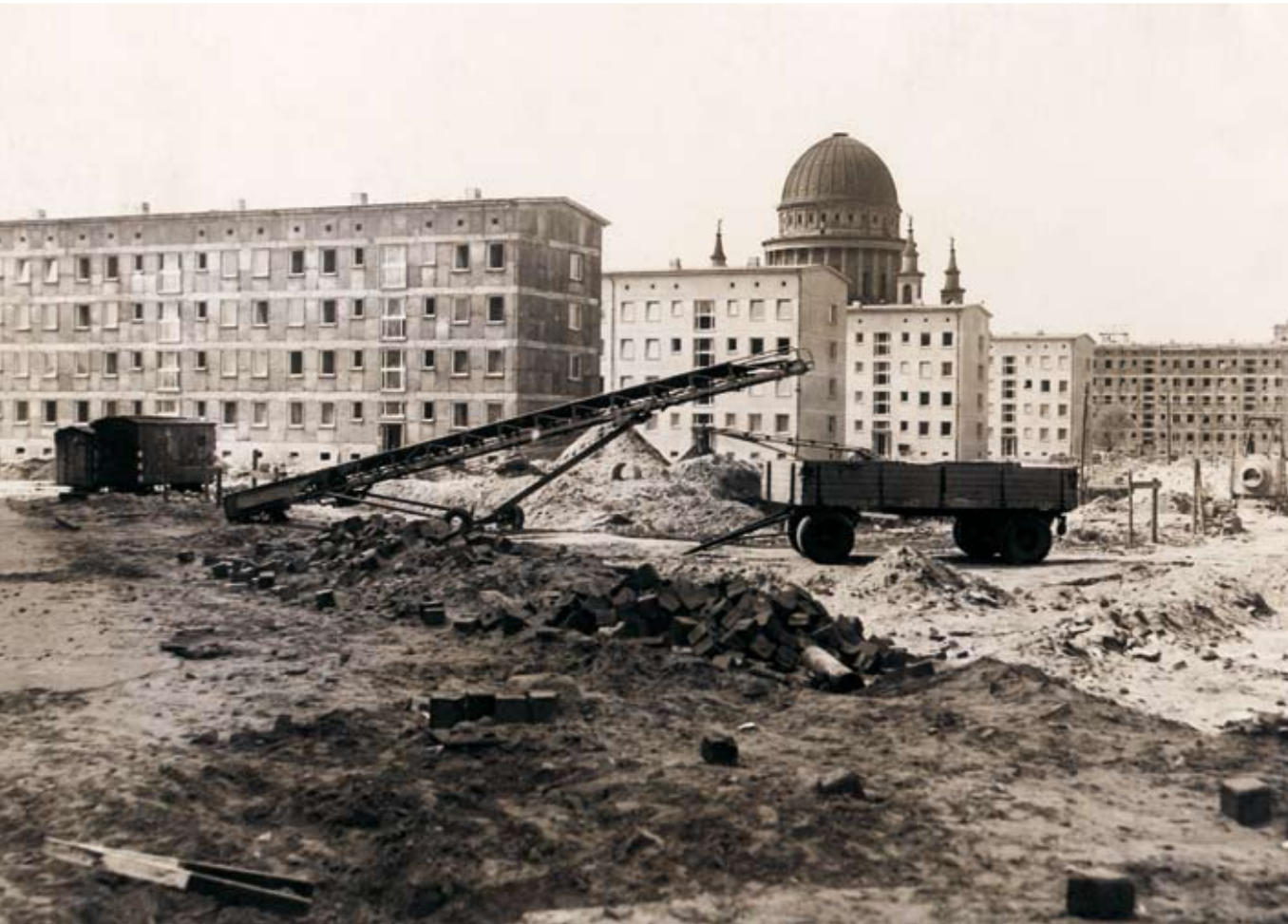
Zentrum Süd, das erste innerstädtische Neubaugebiet entsteht
