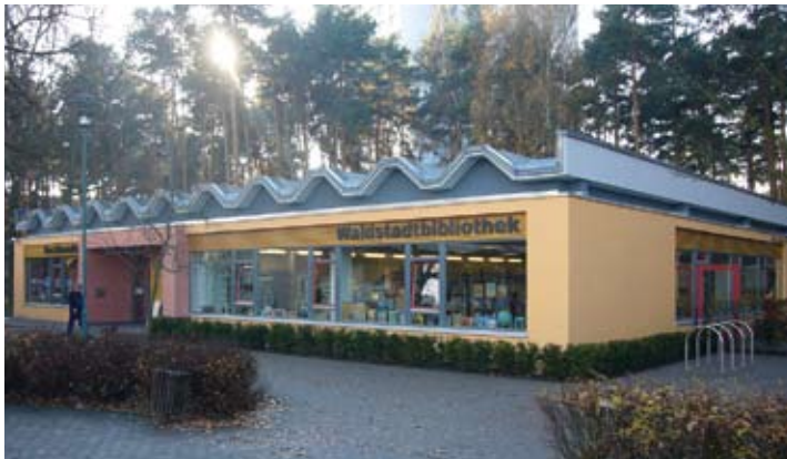
Die Waldstadtbibliothek nach der Sanierung 2007
