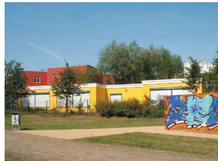
Die sanierte Medienwerkstatt im Jahr 2003
