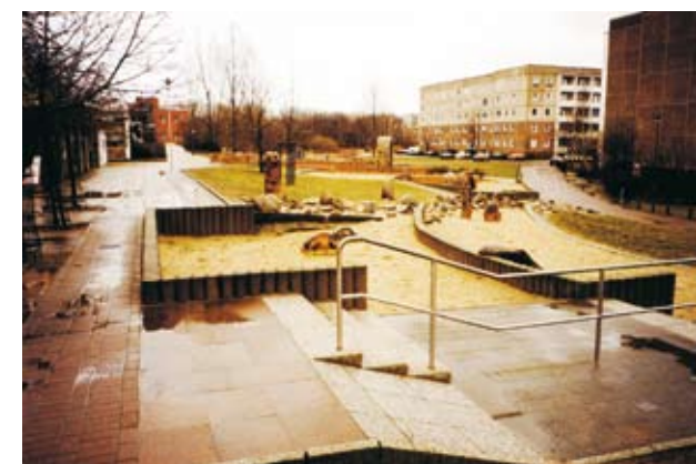
Bereits nach zehn Jahren waren die Freiflächen im Schlaatzer Zentrum erneuerungsbedürftig.
