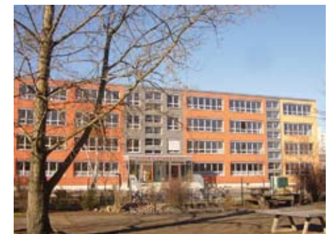
Leibniz-Gymnasium nach der Sanierung, 2008
