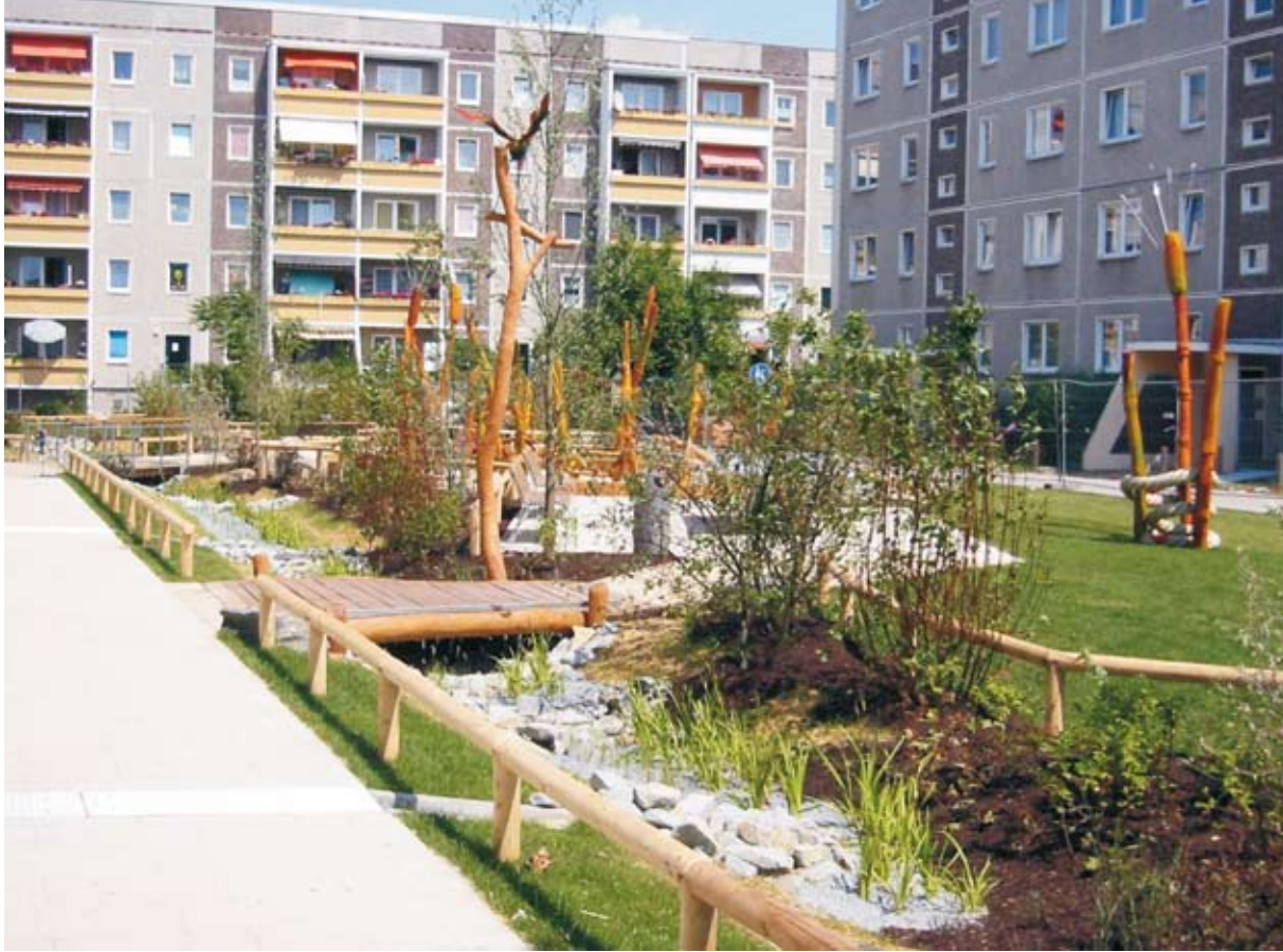
Unter dem Leitmotiv „Wasser“ wurde der Hof umgebaut
