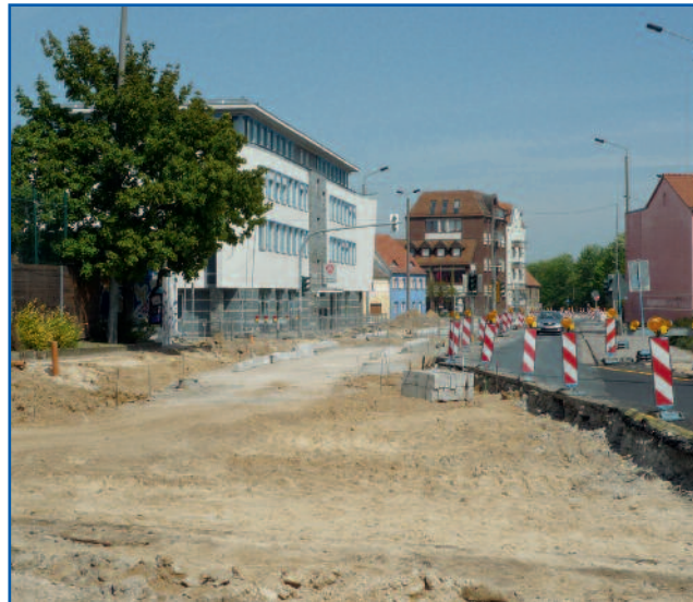
Bauarbeiten am Kreisverkehr, B273
