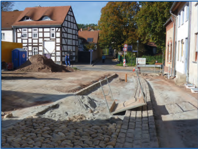
Gebhard-Eckler-Straße während der Bauarbeiten
