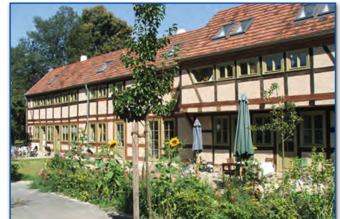
Goethestraße 38 nach der Sanierung
