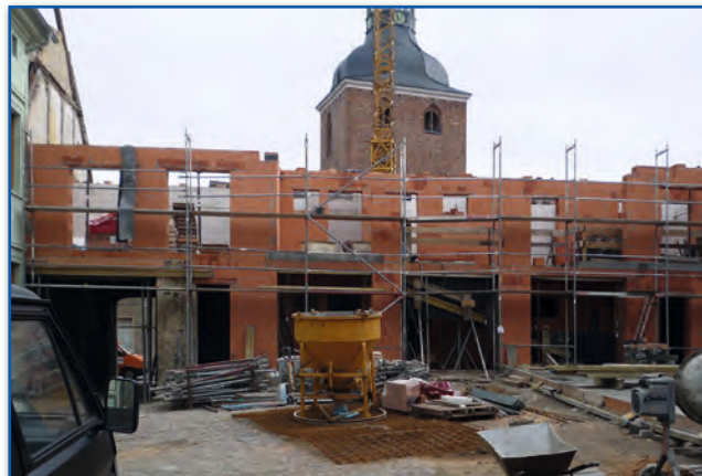
Neubau hinter einer historischen Fassade – Goethestraße 52
