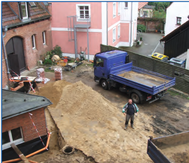
Bauarbeiten im Rathaushof
