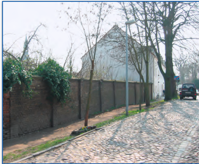
Mauerstraße vor der Sanierung
