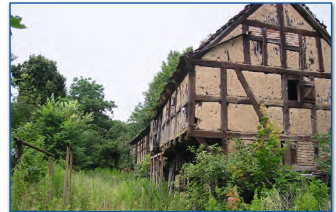
Remise Goethestraße 38 vor der Sanierung
